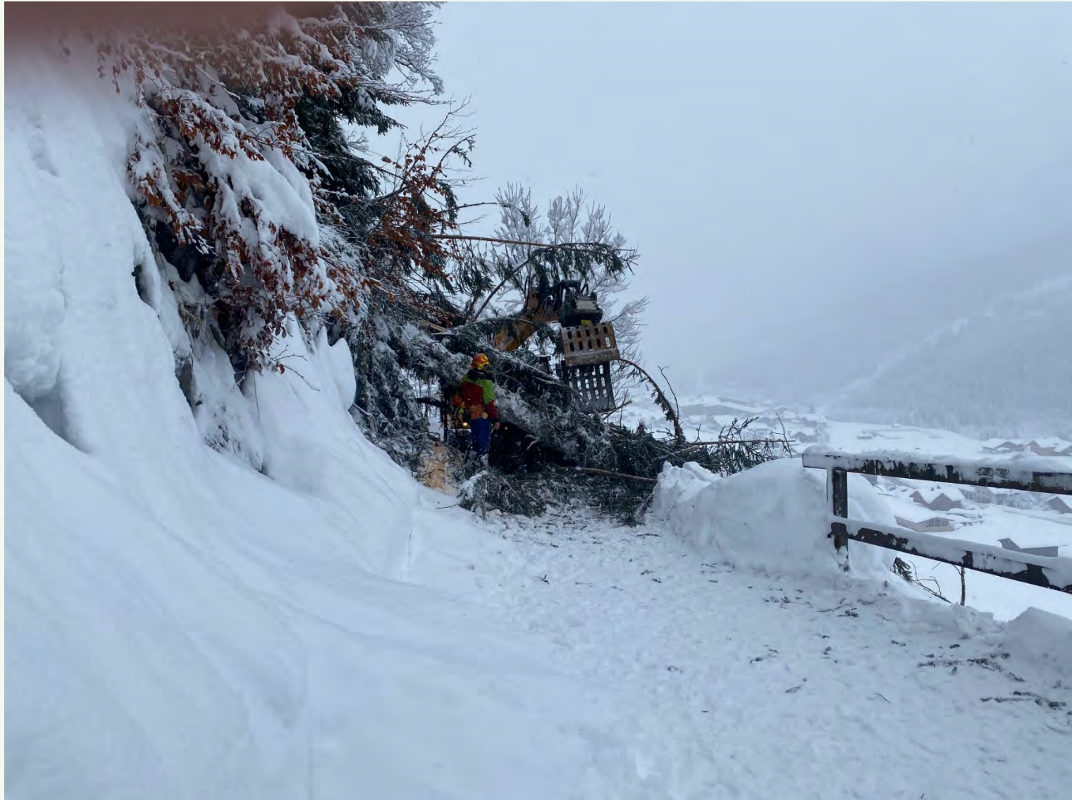
Schneebruch – 2. Dezember 2023 – Stütze Richtung Erlenboden
